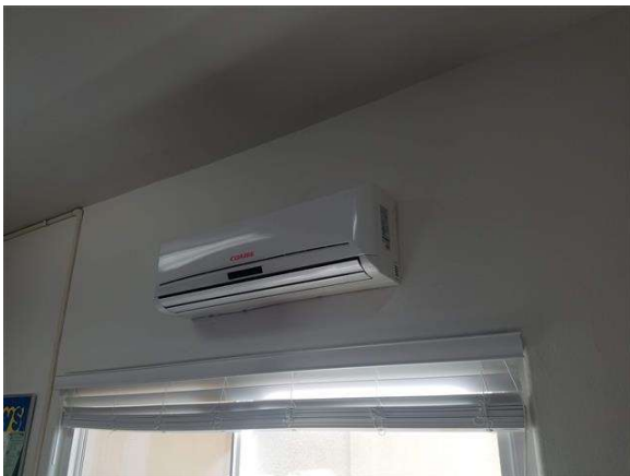
Mini Split System Evaporating Unit
