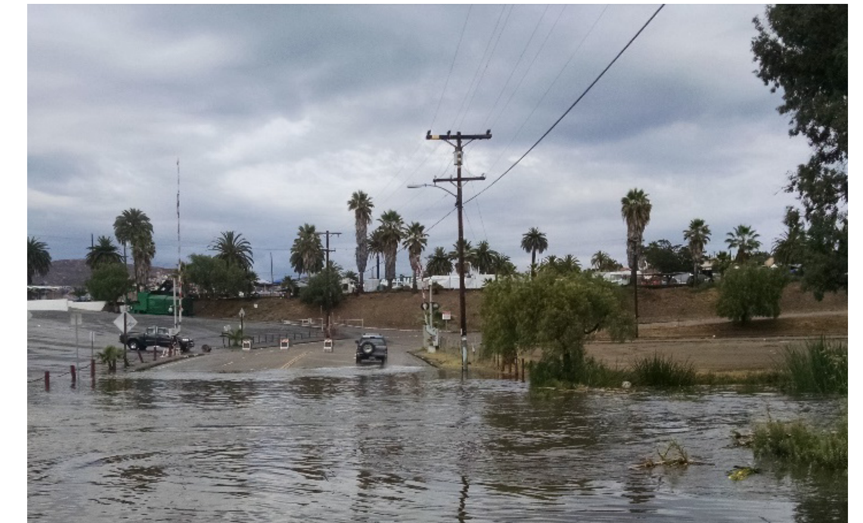
Durante el evento de inundación en Quarry Road
