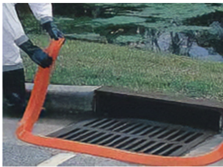
حفاظت ورودی برای جلوگیری از وارد شدن نشستی به زهکش سیلاب.
