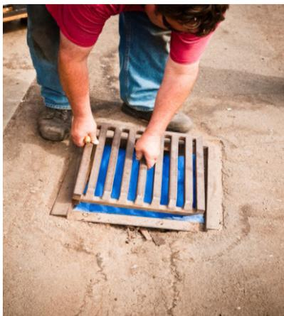
*Se coloca un inserto de filtro azul en el drenaje para recoger la suciedad y los escombros.*
