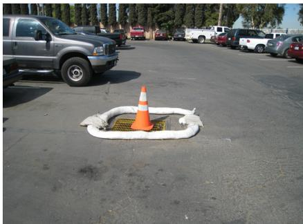
*La entrada de los drenajes (storm drains) en el área de estacionamiento está protegida.*
