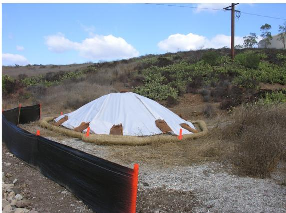
*Una acumulación de tierra se cubre con una lona, protegida con rollos de fibra y una cerca de limo.*
