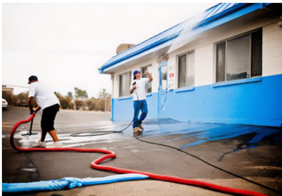
*Se utiliza una aspiradora de líquidos y calcetines absorbentes para recoger el agua de lavado del techo.*
