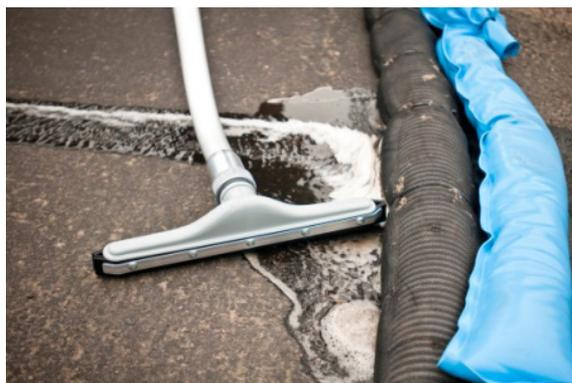
*El agua de lavado se recoge con una aspiradora de líquidos y calcetines absorbentes.*
