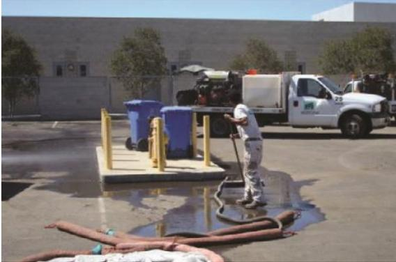
*La entrada de los drenajes (storm drains) está protegida mientras se limpia el pavimento.*
