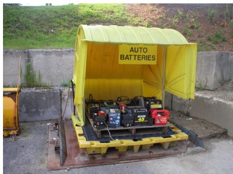
*Las baterías de automóviles se elevan del suelo y se almacenan debajo de áreas cubiertas.*
