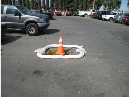
Miệng cống thoát nước mưa trong khu vực đậu xe được bảo vệ.
