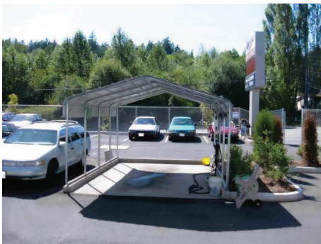
Khu vực rửa xe chuyên dụng có mái che, bờ ngăn và thoát ra cống vệ sinh
