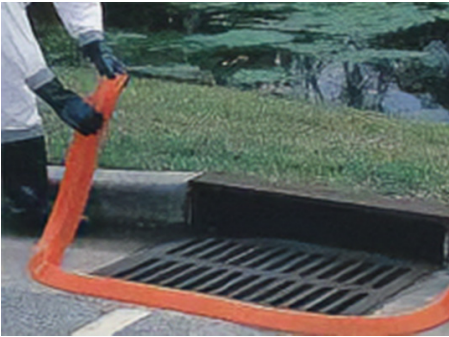
Bảo vệ miệng cống để ngăn nước tràn vào cống thoát nước mưa.
