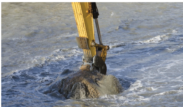
NAO VẾT — Loại bỏ bùn và vật liệu khác từ đáy của các vùng nước.
